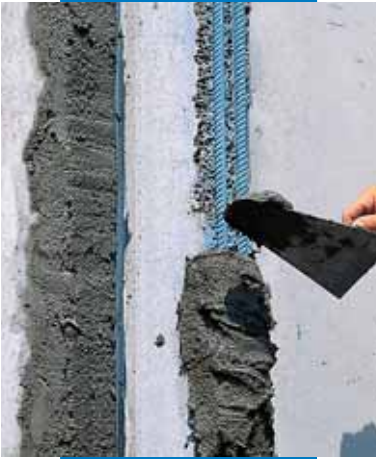
Нанесение раствора мастерком
